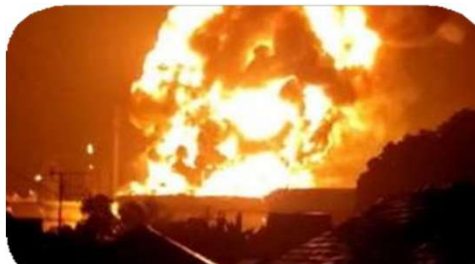
Kebakaran tangki RU IV Cilacap (13 Nov 2021)
