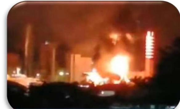
Kebakaran Unit CDU IV RU V Balikpapan (25 Mei 2024)
