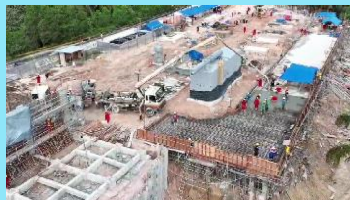
Mempercepat Pekerjaan Platform untuk akses alat dan material
