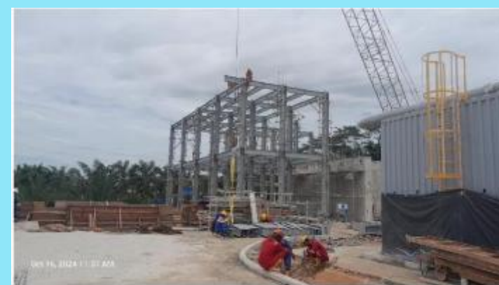
Merubah Struktur Beton menjadi Baja MCC Room
