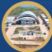
Instalasi Pengolahan Air Bersih Kapasitas 285 L/s
